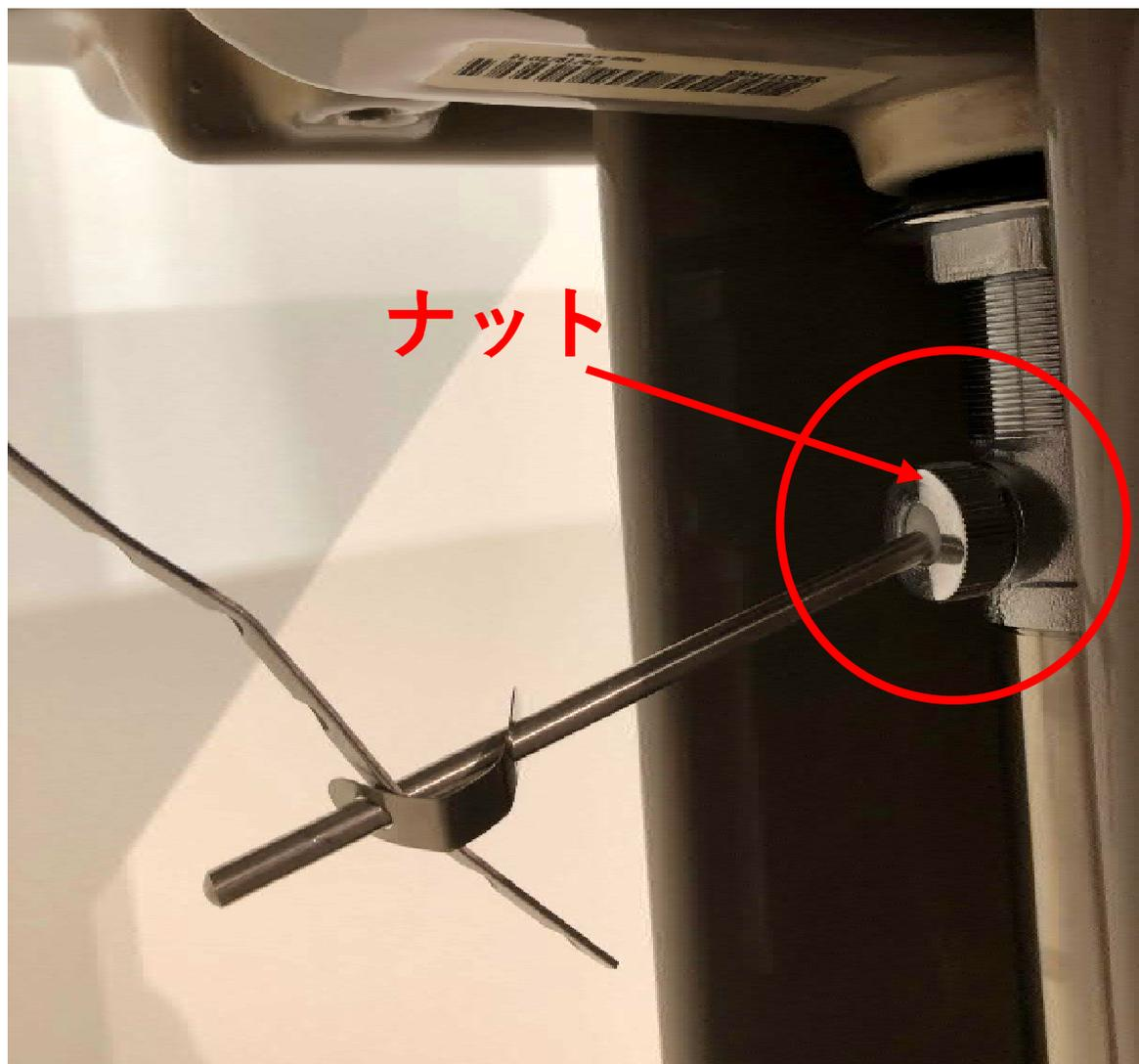
横ロッドと排水金具の接続部にあるナットを締めすぎている可能性がありますので、その場合はナットを少し緩めてください。
