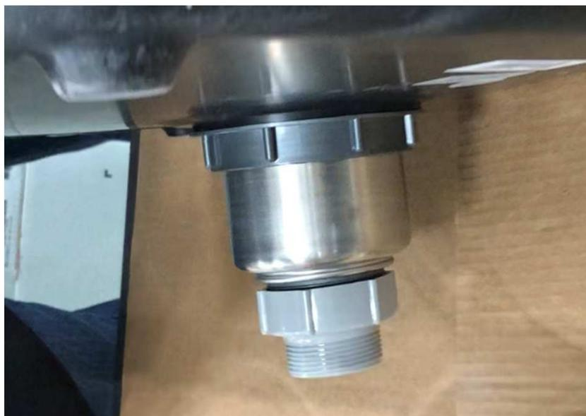
シンク裏側よりゴムパッキン(シンク裏側用)、ナットの順番に本体へ取付け、ナットを回して排水金具を固定します。
