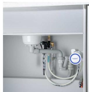
シンク下3点設置：カートリッジは場所を取らないアンダーカウンター式で引き出しにも対応可能です。
